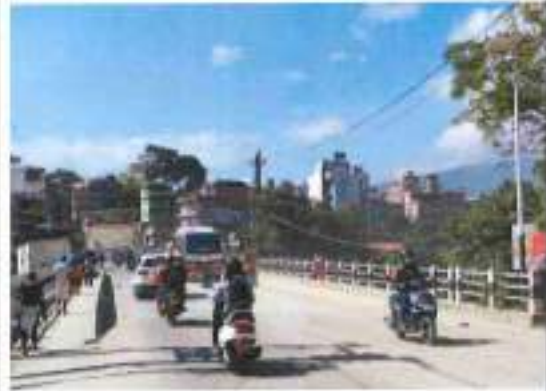
नख्खु खोला पुल
