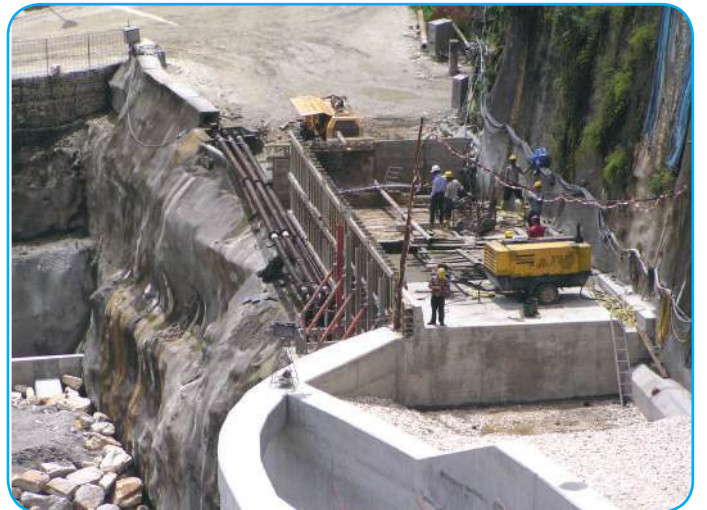
construction site (Middle Marsyangdi HPS)
